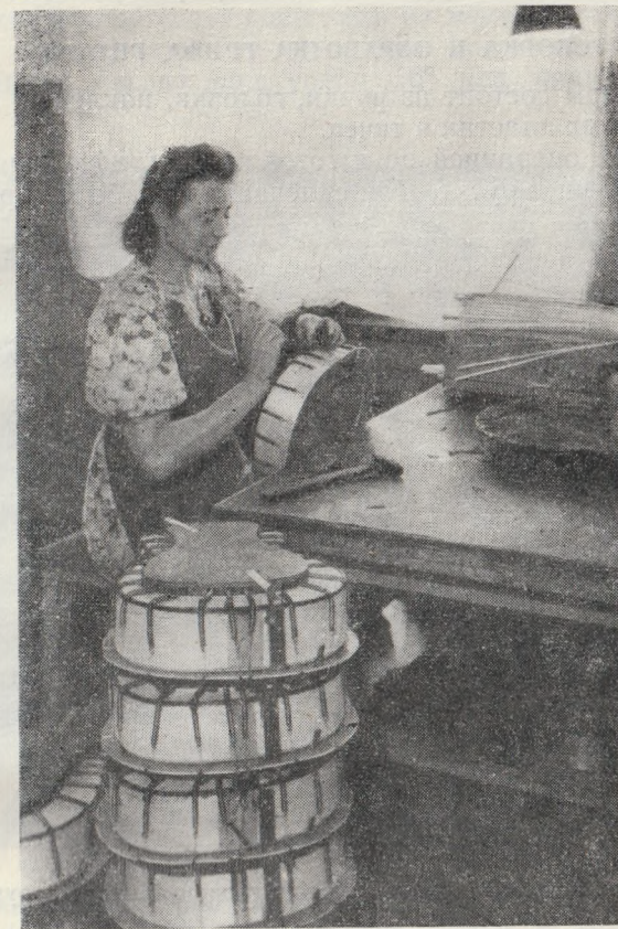
Рис. 81. Окантовка корпуса гитары
